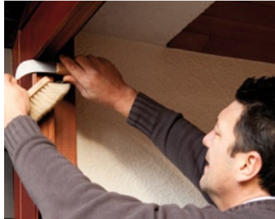
... damit die neuen, selbstklebenden Vorlegebänder in der Rahmeninnenseite gut halten.
