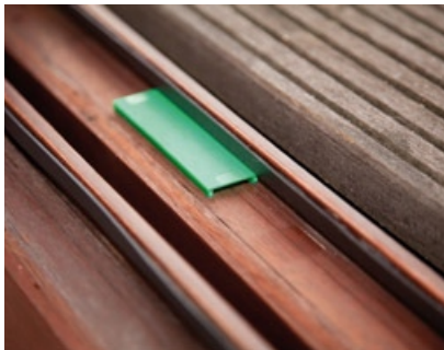
Verglasungsklotze aus Kunststoff in der Rahmenunterseite verhindern, dass die neue Scheibe beim Einsetzen mit dem Holz in Kontakt kommt.
