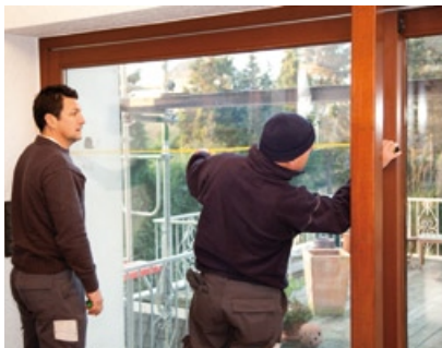
Sicher ist sicher: Ein letztes Mal misst der Glasermeister die Größe der alten Scheiben nach.
