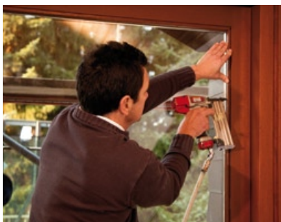
Die alten Leisten werden wieder an der Rahmeninnenseite befestigt, sie werden „angeschossen“.
