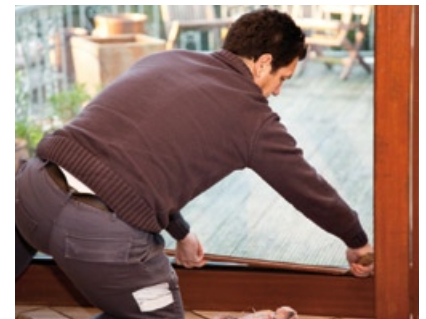
... dann ebenso vorsichtig abgehelt. Im Regelfall können die alten Leisten wiederverwendet werden.
