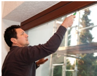
Die Demontage der alten Scheiben beginnt: Zunächst werden die Leisten auf der Rauminnen-seite vorsichtig gelockert und ...
