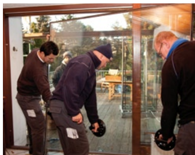
Um die schweren Scheiben sicher packen zu können, platzieren die Glaser im unteren Drittel drei Vakuumsauger.
