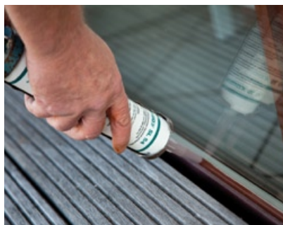
Der letzte Schritt: In einem Durchgang wird die Scheibe mit Silikon versiegelt, um die Dichtigkeit sicher zu stellen.
