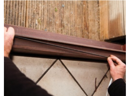
Die Vorlegebänder verhindern, dass die Scheiben direkt den Holzinnenrahmen berühren und ermöglichen, dass beim späteren Versiegeln eine fachgerechte Dreiecksfuge gezogen werden kann.
