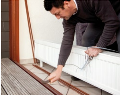
Die Glaser entfernen die alten Vorlegebänder, Silikonbänder und andere Rückstände gründlich von der Rahmeninnenseite, ...
